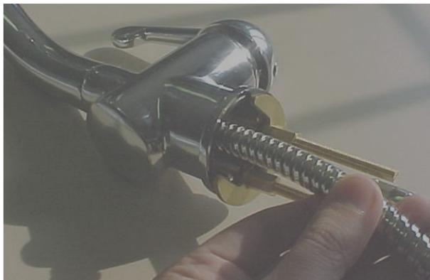
**5-** Enrosque las dos conexiones de 35 cm al grifo correspondientes al agua fría y al agua caliente.
